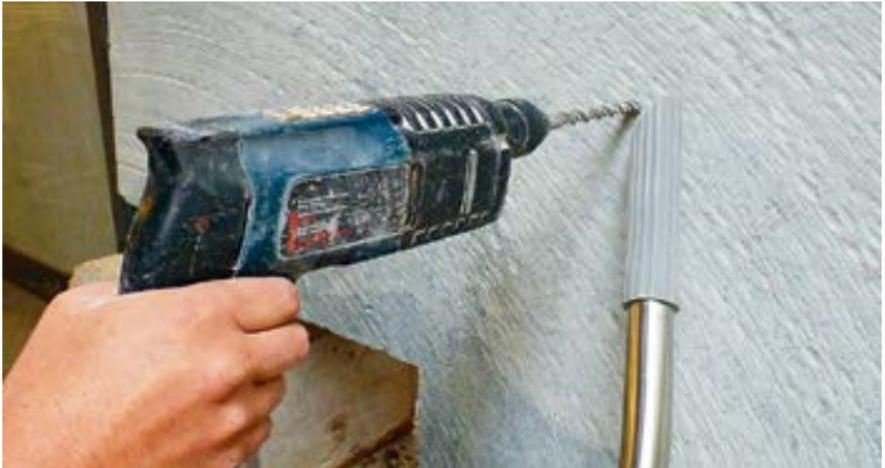
Beim Bohren in Serpentin ist eine Quellenabsaugung einzusetzen.
