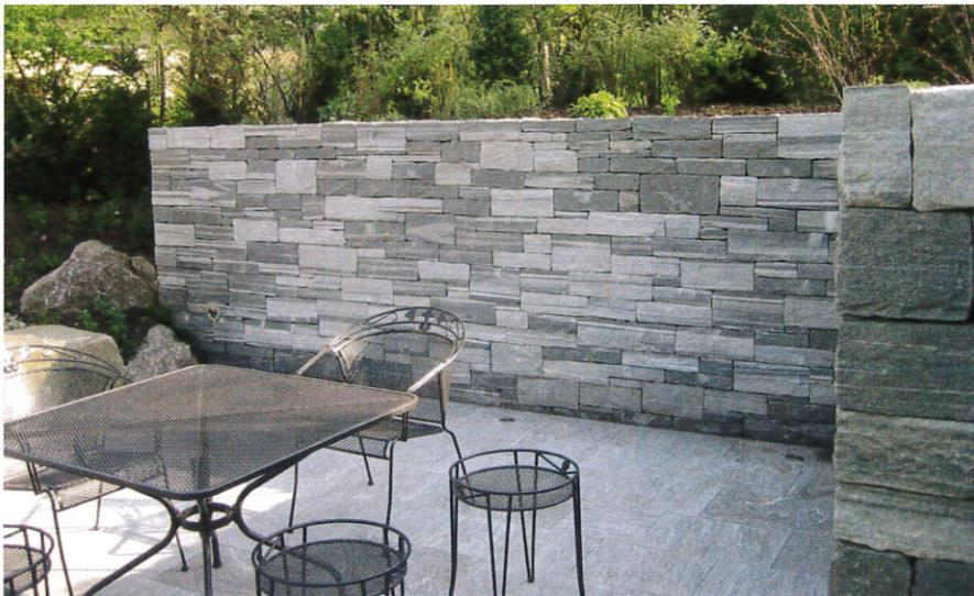
Gneis-Schichtenmauerwerk mit Pressfugen ohne Mörtel.
